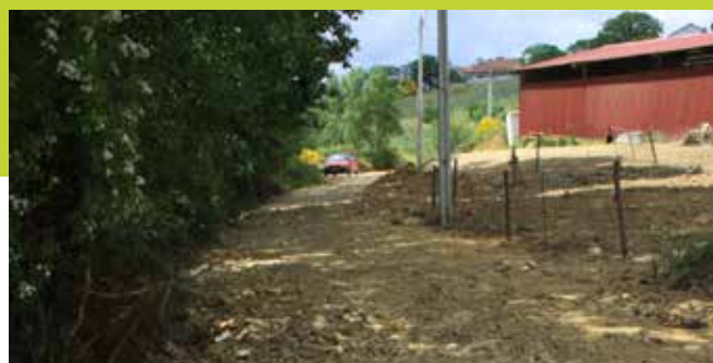
ABERTURA DE CAMINHO RURAL
