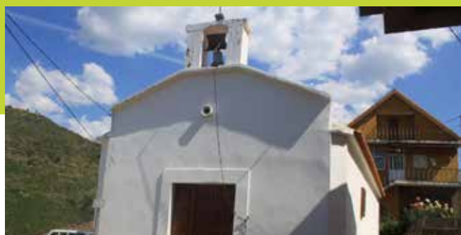
SENDIM - PINTURA DO CEMITÉRIO
