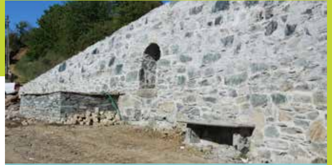
MURO DA MÃE DE ÁGUA VELHA
