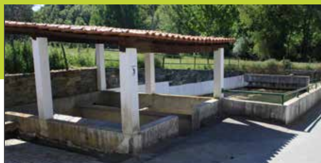
PINTURA DOS TANQUES E LAVADOUROS, A INICIAR
