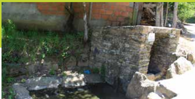
LAGARELHOS - RECUPERAÇÃO DE FONTES
