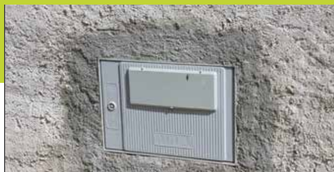
SALGUEIROS - COLOCAÇÃO DE CONTADORES
