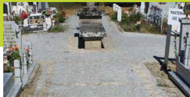
COLOCAÇÃO DE PARALELOS NO CEMITÉRIO
