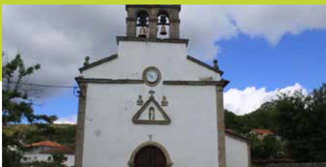
SOBREIRÓ DE BAIXO - IGREJA
