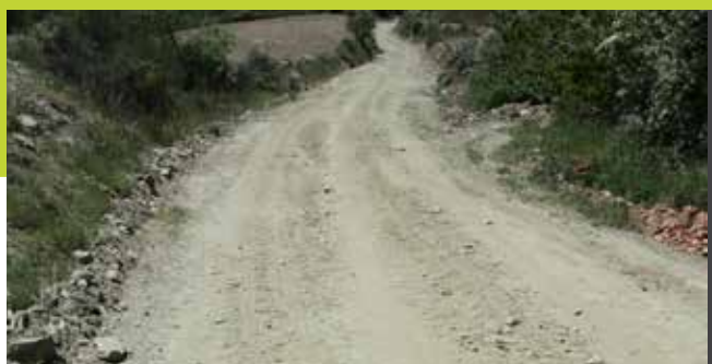
LIMPEZA DE CAMINHOS RURAIS
