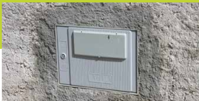
COLOCAÇÃO DE CONTADORES
