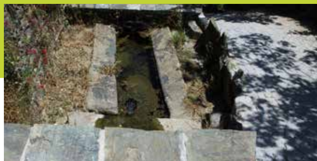
LAGARELHOS - RECUPERAÇÃO DE FONTES
