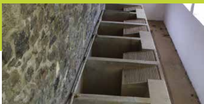
VILAR DE OSSOS - TANQUES DE LAVAR
