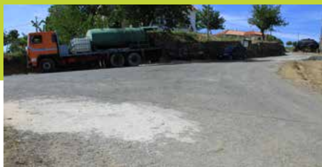
PENSO - RUAS PARA ASFALTO
