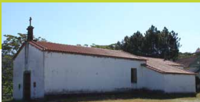
ARRANJO DO TELHADO E PINTURA DA CAPELA DA SRª DOS REMÉDIOS
