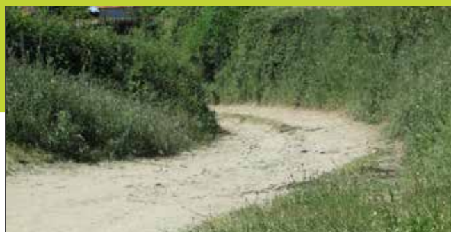
ARRUAMENTO PARA ASFALTAR, BREVEMENTE
