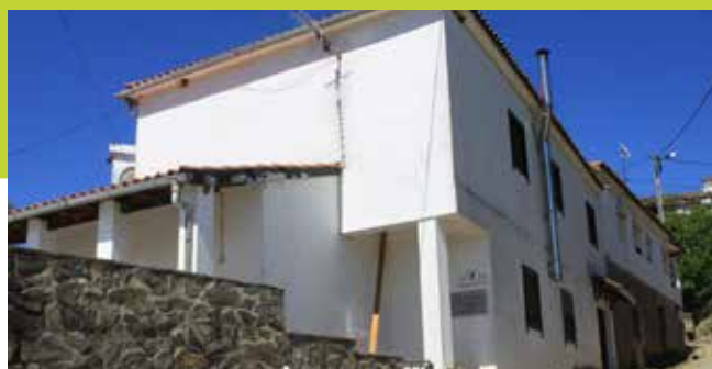
RECUPERAÇÃO DA SEDE DA JUNTA
