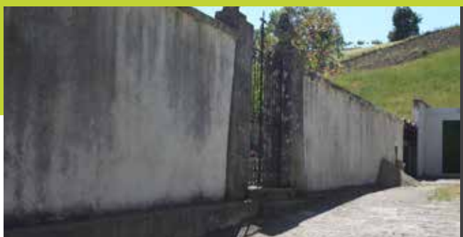
PINTURA DOS MUROS DO CEMITÉRIO, A INICIAR
