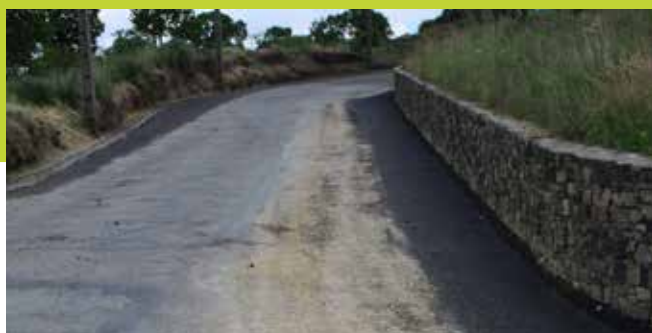
ALARGAMENTO DE ARRUAMENTOS
