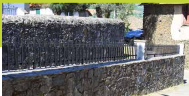
MURO DA IGREJA
