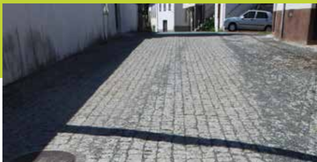
COLOCAÇÃO DE PARALELOS NA IGREJA
