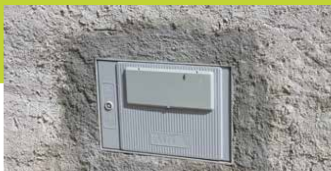
COLOCAÇÃO DE CONTADORES
