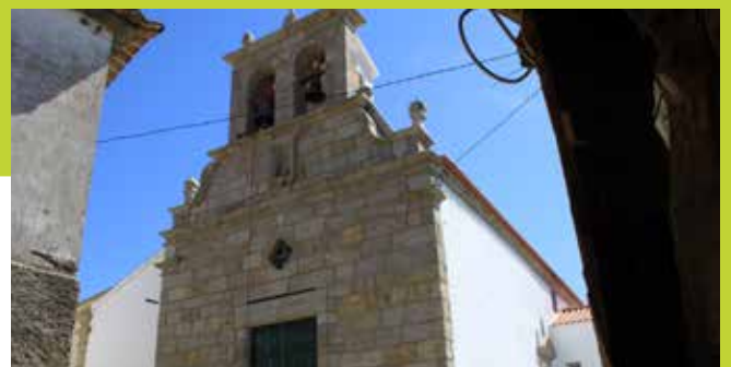
RESTAURO DA IGREJA
