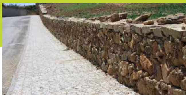
MURO EM PEDRA NA ENTRADA DA ALDEIA
