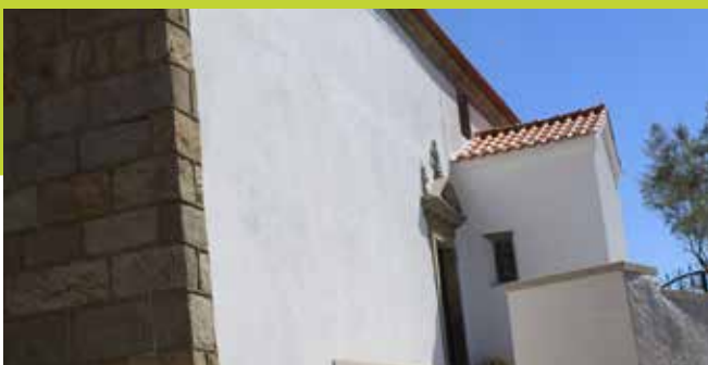
RESTAURO DA IGREJA
