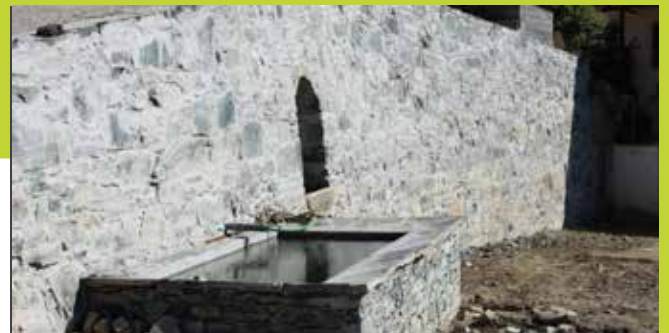
MURO DA MÃE DE ÁGUA VELHA
