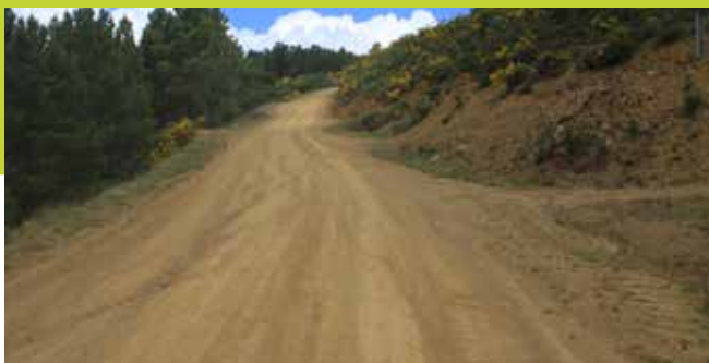
LIGAÇÃO DE SOBREIRÓ DE BAIXO À ESTRADA NACIONAL 103 PARA ASFALTAR
