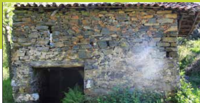
INICIO DA RECUPERAÇÃO DO MOINHO DE PARADA
