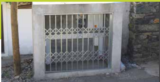
ESTAÇÃO ELEVATÓRIA DE SANEAMENTO
