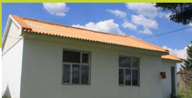
RESTAURO DA ESCOLA ONDE FUNCIONA OS CTT E GABINETE DE FISIOTERAPIA
