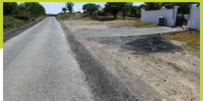
ESTRADA DE SANTALHA - PENSO PARA ASFALTAR
