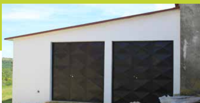
SANTALHA - ARMAZEM DA JUNTA DE FREGUESIA
