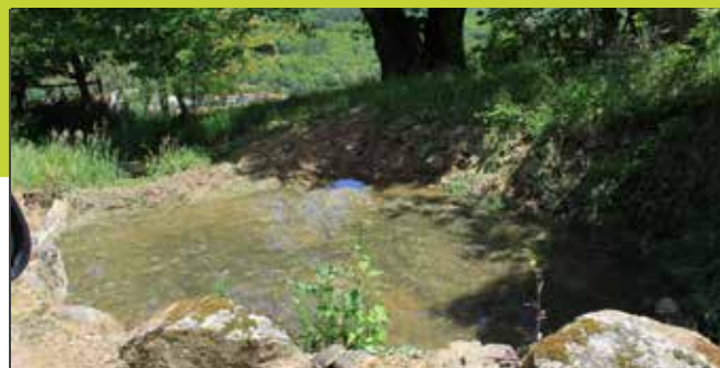
LAGARELHOS - RECUPERAÇÃO DE FONTES
