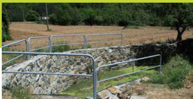
LAGARELHOS - RECUPERAÇÃO DE FONTES
